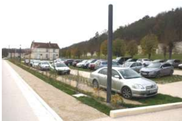
Stationnement créé récemment à Clairvaux pour le personnel de la maison centrale
