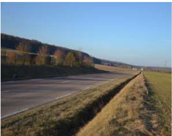
Entrée de ville par la RD396
