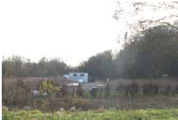
Station d'épuration visible depuis le parking du restaurant
