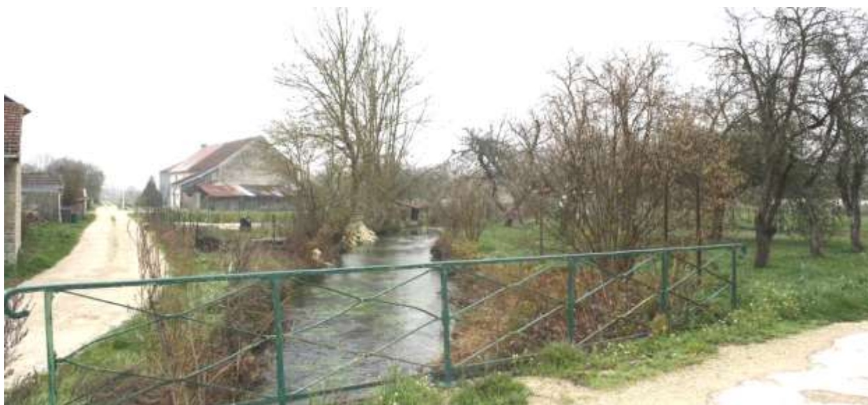
Le canal des Moines dans le bourg de Ville-sous-la-Ferté
