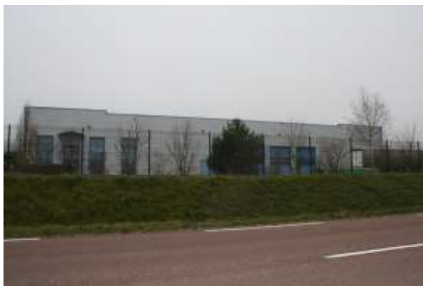
Bâtiment récents de BMT production
