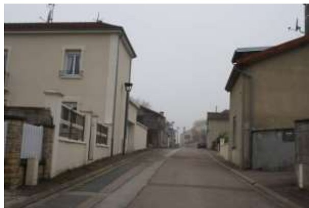
Construction à l'alignement
