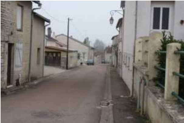
Voirie ancienne avec peu de place pour les trottoirs
