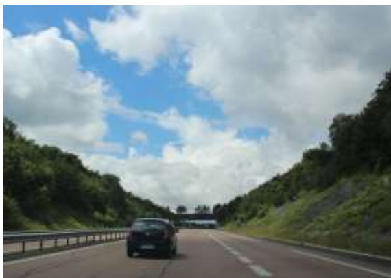
Ecoduc sur l'autoroute A5
