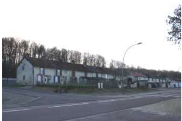
Les alignements de maisons ouvrières en R+1
