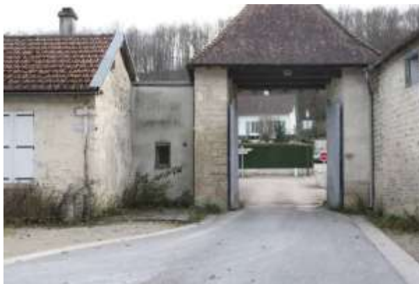
Le contraste entre l'enceinte historique en pierre et une construction récente en arrière-plan
