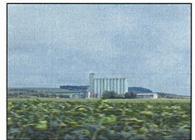
Silo au Sud
