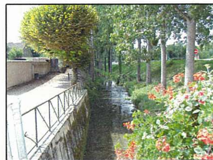
La Noxe canalisée
