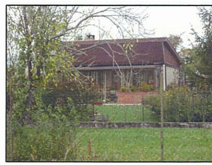
Toiture de pente atypique
