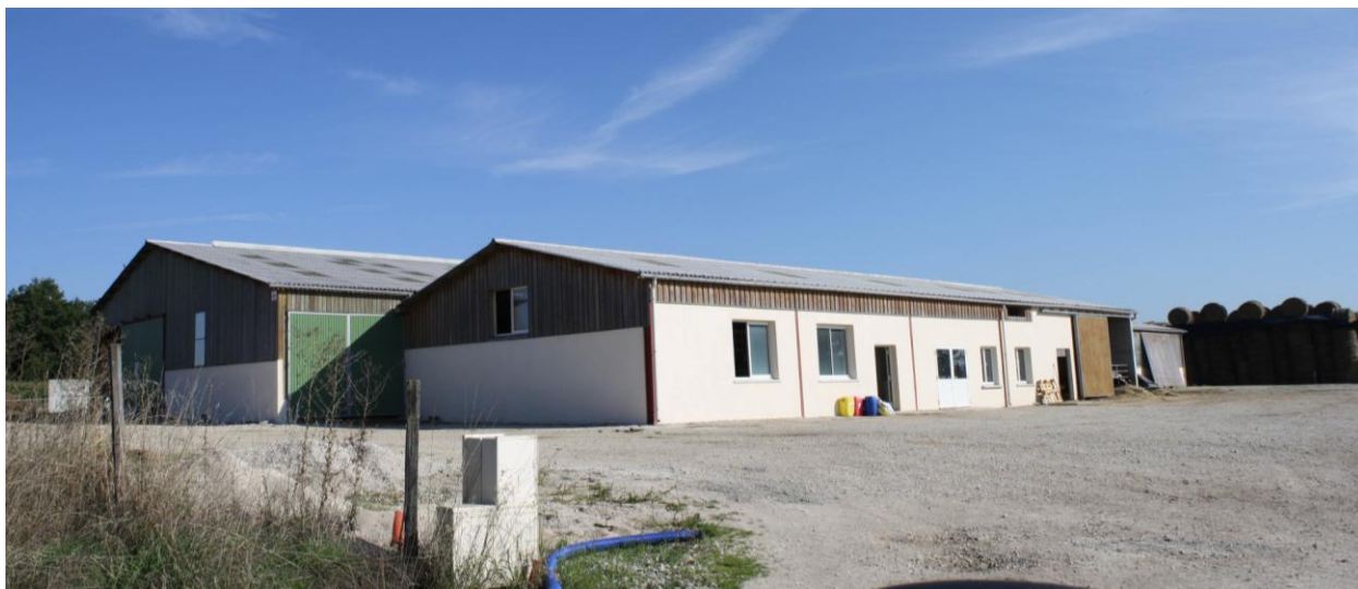
Nouveau hangar agricole, inscrit en aval du hameau de Haut-Villeneuve
