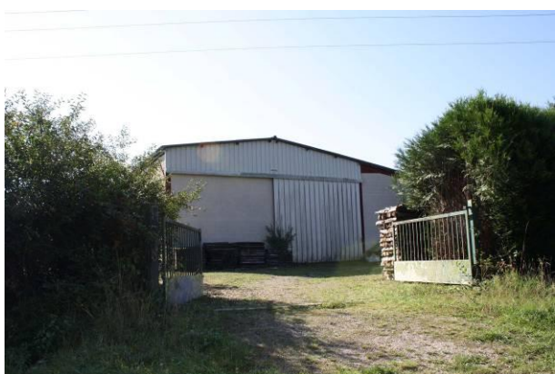
Hangar d'une activité – Nord du lieu-dit Saint-Roch
