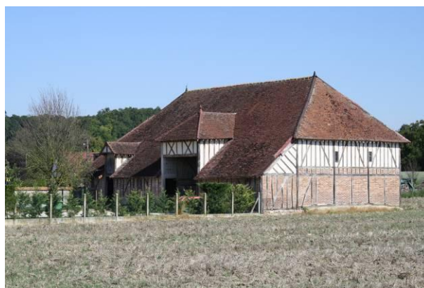
Grange- hameau de Courbeton – RD49
