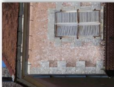
Pierre de taille et maçonnerie enduite, Molins-sur-Aube
