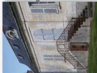
Toiture ardoise à brisis, Lesmont
