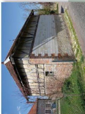
Construction composite : pierre calcaire, craie, brique, pan de bois, apparent à remplissage maçonné enduit, tuile plate, Molins-sur-Aube
