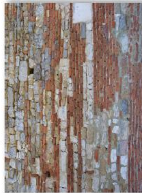
Maçonnerie mixte brique, pierre calcaire, craie, Montiermercy
