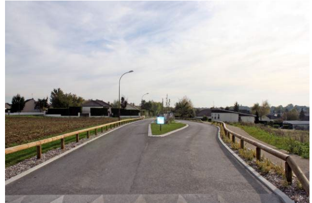
Aménagements à l'entrée Nord du bourg en provenance de Rouilly-Saint-Loup
