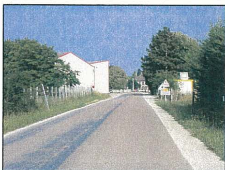
Problème d'intégration des bâtisses
