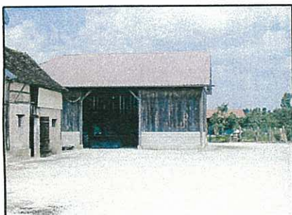
Bâtiment agricole, rue du Rué
