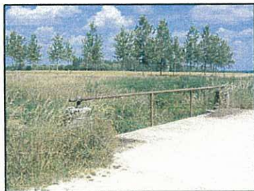
Pont, fossé Berthault
