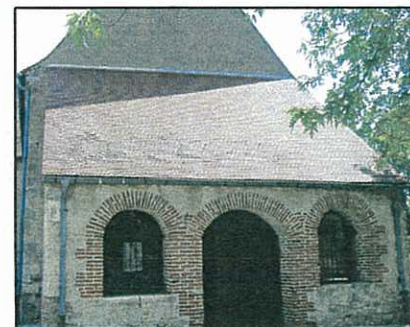
Brique en mur porteur et modénatures
