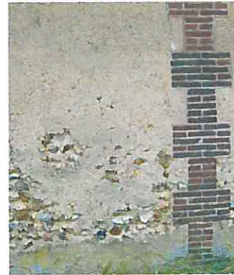
Lourd, solide et ne craignant pas l'eau, le silex se retrouve en partie basse des maçonneries. Irrégulier, son agencement nécessite beaucoup de mortier et un enduit protecteur. Parfois les dessins de l'enduit imitent la pierre de taille qui reste la référence
