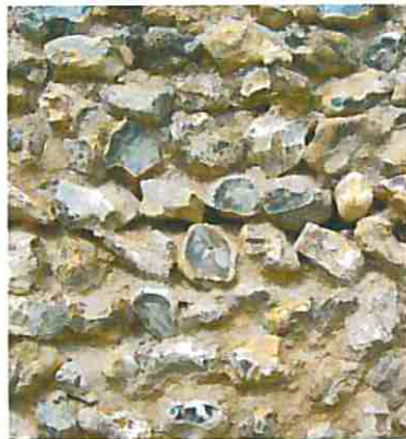
Lourd, solide et ne craignant pas l'eau, le silex se retrouve en partie basse des maçonneries. Irrégulier, son agencement nécessite beaucoup de mortier et un enduit protecteur. Parfois les dessins de l'enduit imitent la pierre de taille qui reste la référence
