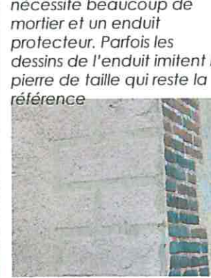
Lourd, solide et ne craignant pas l'eau, le silex se retrouve en partie basse des maçonneries. Irrégulier, son agencement nécessite beaucoup de mortier et un enduit protecteur. Parfois les dessins de l'enduit imitent la pierre de taille qui reste la référence
