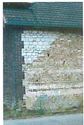
Lourd, solide et ne craignant pas l'eau, le silex se retrouve en partie basse des maçonneries. Irrégulier, son agencement nécessite beaucoup de mortier et un enduit protecteur. Parfois les dessins de l'enduit imitent la pierre de taille qui reste la référence
