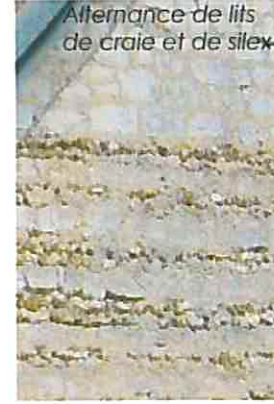
Lourd, solide et ne craignant pas l'eau, le silex se retrouve en partie basse des maçonneries. Irrégulier, son agencement nécessite beaucoup de mortier et un enduit protecteur. Parfois les dessins de l'enduit imitent la pierre de taille qui reste la référence
