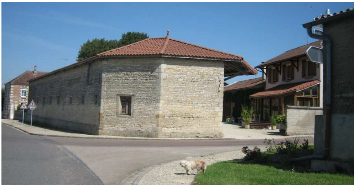
Bâtiment ancien en pierre
