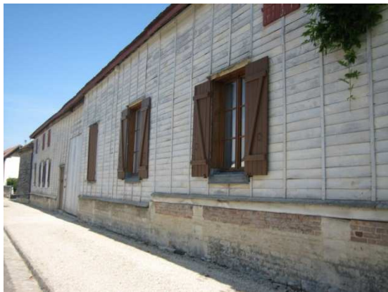
Pan de bois couvert de bardage rénové / abandonné
