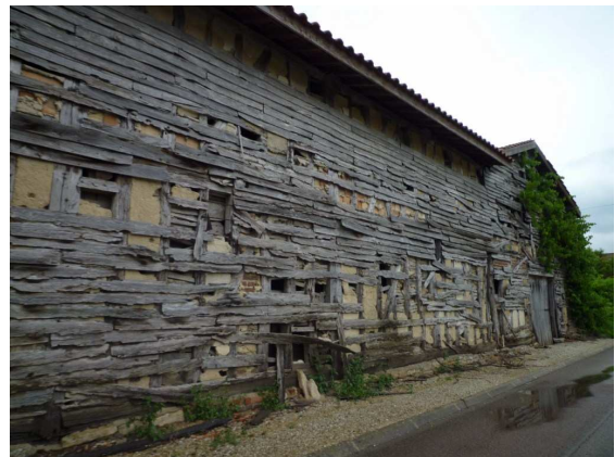
Pan de bois couvert de bardage rénové / abandonné
