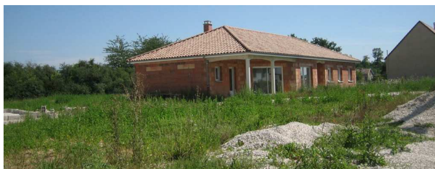
Maison en construction à l'Ouest du hameau
