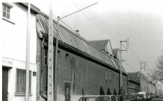
Etat d'origine - Vue de depuis la rue Brulard
