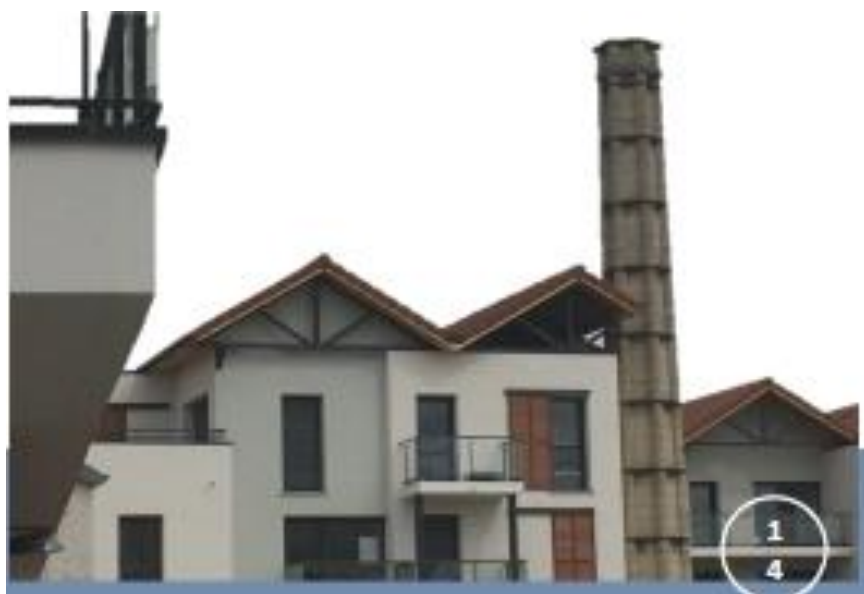
Figure 15 : Etat actuel - Vue depuis l'intérieur de l'îlot. La cheminée, une présence forte mais anecdotique, U2A.
