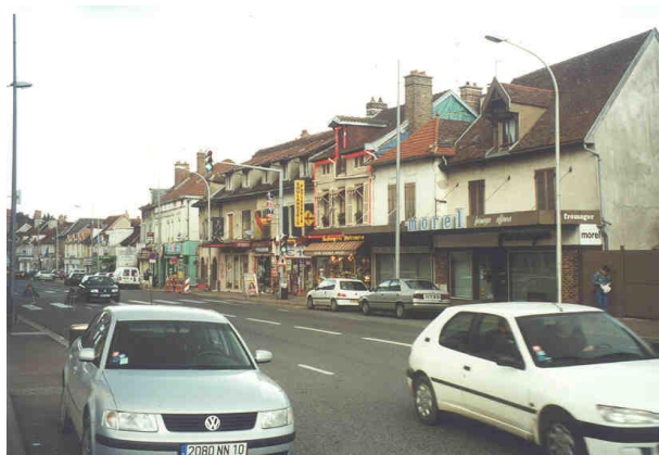
Exemple de bâti de Faubourg Avenue Pierre Brossolette
