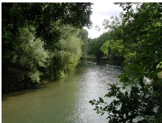
Digue de Fouchy
