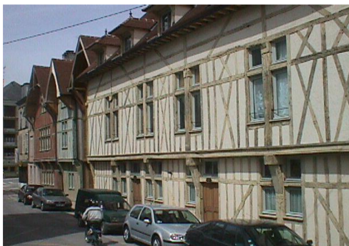
Maisons à pans de bois rue Simart
