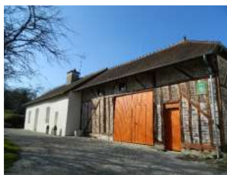
Ancien bâtiment agricole réhabilité en logement
