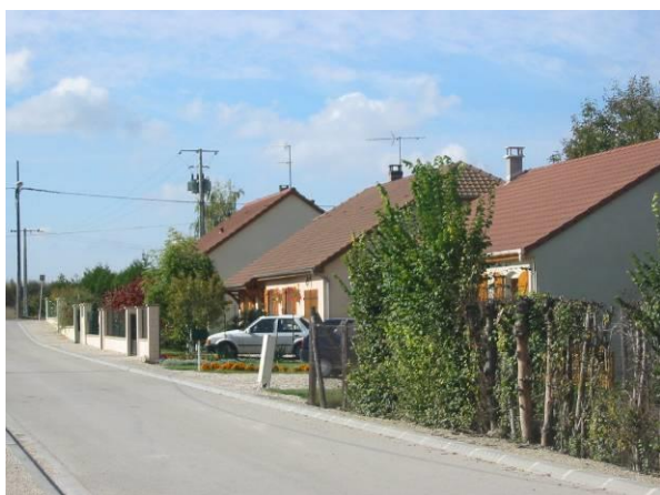
Groupe d'habitations rue de la Ferme
