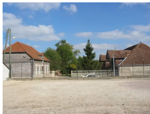
Corps de ferme voie face église
