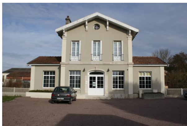
La bibliothèque installée dans l'ancienne gare.
