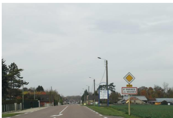
Entrée décalée entre l'urbanisation existante sur le côté gauche et la présence du panneau d'entrée à droite.
