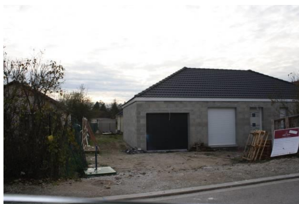
Construction récente à proximité du site
