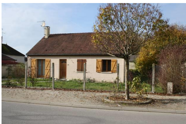
Habitation années 80 – volume simple – création de baie vitrée
