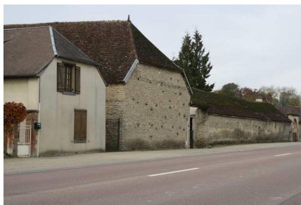
Implantation à l'alignement – vue sur site
