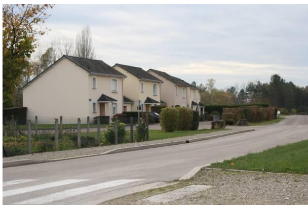
Maison récente – construction accolée – création d'une unité bâtie
