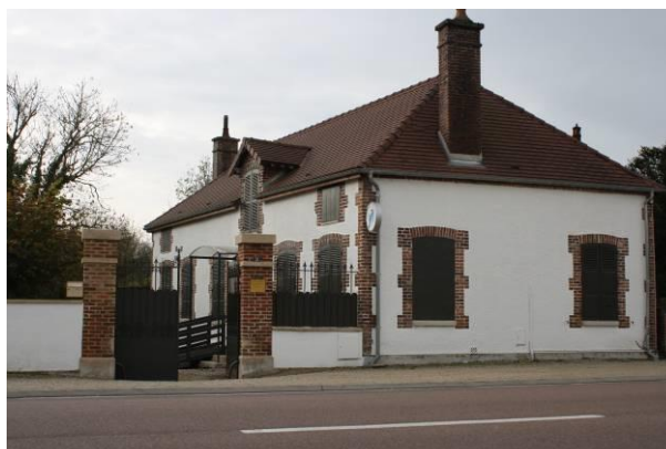
Habitation ancienne rénovée – toiture tuile – tours de fenêtre en briques
