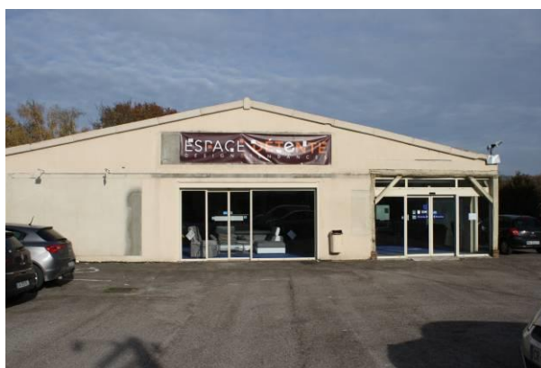
Commerce dans un « hangar » - recul du bâtiment par rapport à l'alignement - intégration difficile - façade peu qualitative
