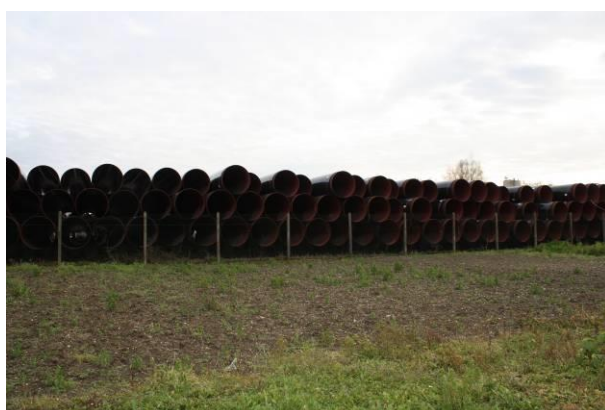
Le stockage pour le pipeline de gaz
