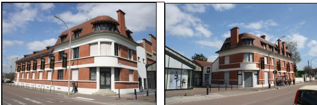
Façades Ouest - « Bâtiment 1 »
