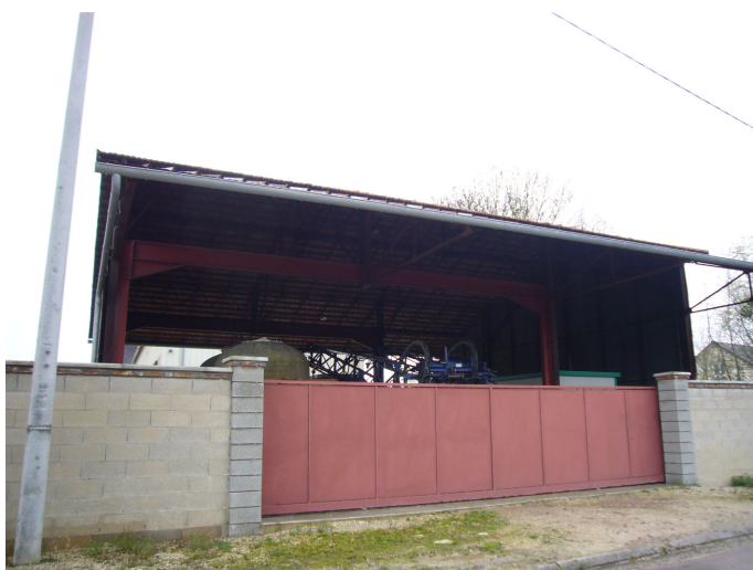
Bâtiment agricole rue des Riots
