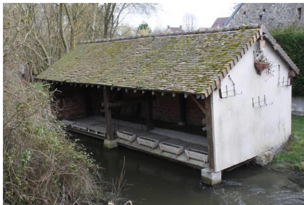
Lavoir rue du Colombier
