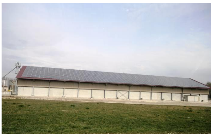
Bâtiment, ferme de la Crouillère
