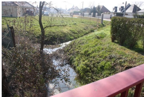
Passage du ru sous la Grande rue du village
