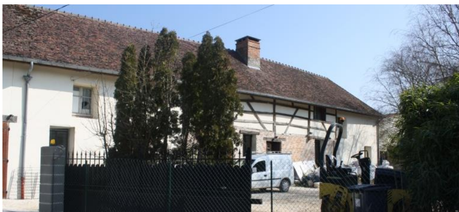
Longère en rénovation rue des Charmottes
