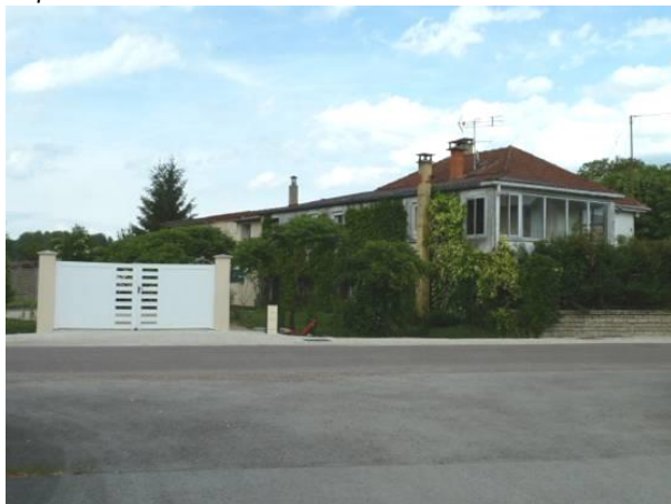
Véranda en extension – portail contemporain
