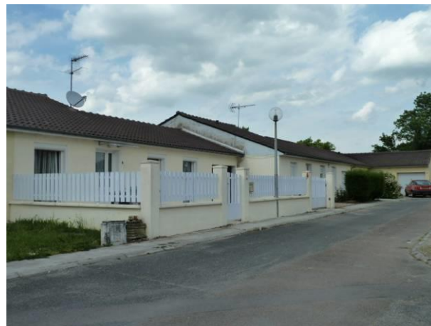
Maisons de plein pied, accolées
