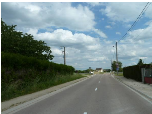
La RD21, une emprise large mais conservation des trottoirs en stabilisé – une ambiance mi-rurale, mi-urbaine
