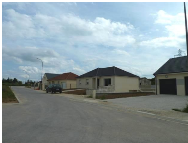
Constructions sur sous-sols, mélange de teintes de toiture
