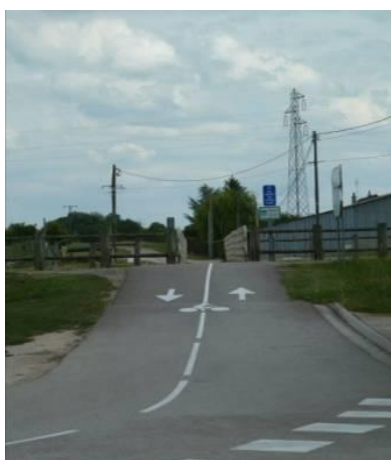
Passerelle sur le Canal
