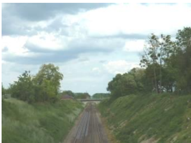
Vue depuis le pont franchissant la voie ferrée à Rouilly-Saint-Loup
