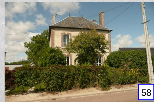
Symétrie caractéristique des maisons « bourgeoises »... L'appareillage des briques crée l'élément de décor. Les souches de cheminées, les toitures à 4 pans en ardoises rendent les bâtisses imposantes.
