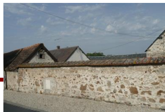
Mur de pierres non enduit et recouvert de tuiles. Le bâti se prolonge et traite les limites séparatives.
