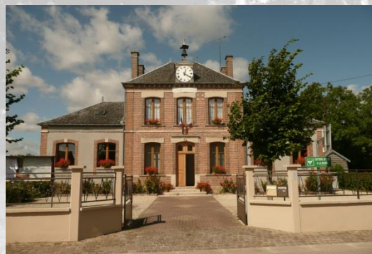
Symétrie caractéristique des maisons « bourgeoises »... L'appareillage des briques crée l'élément de décor. Les souches de cheminées, les toitures à 4 pans en ardoises rendent les bâtisses imposantes.
