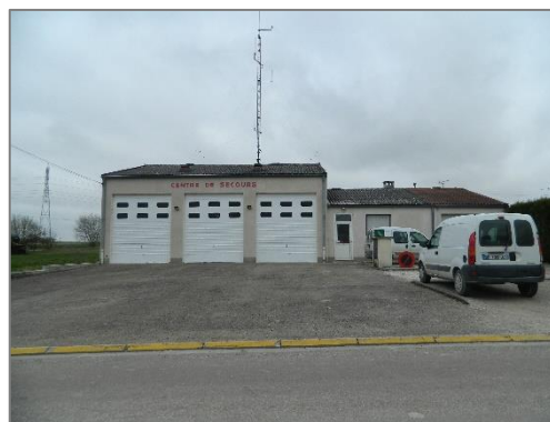
Centre de secours de Ramerupt
