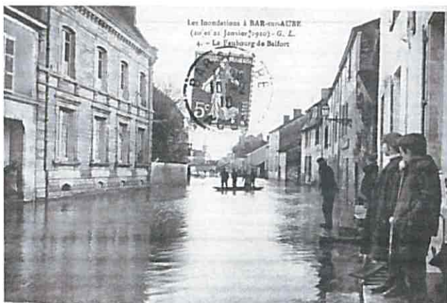
Bar-sur-Aube : Crue de 1910
