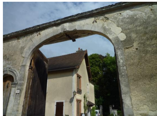
Porche ouvrant sur cour
