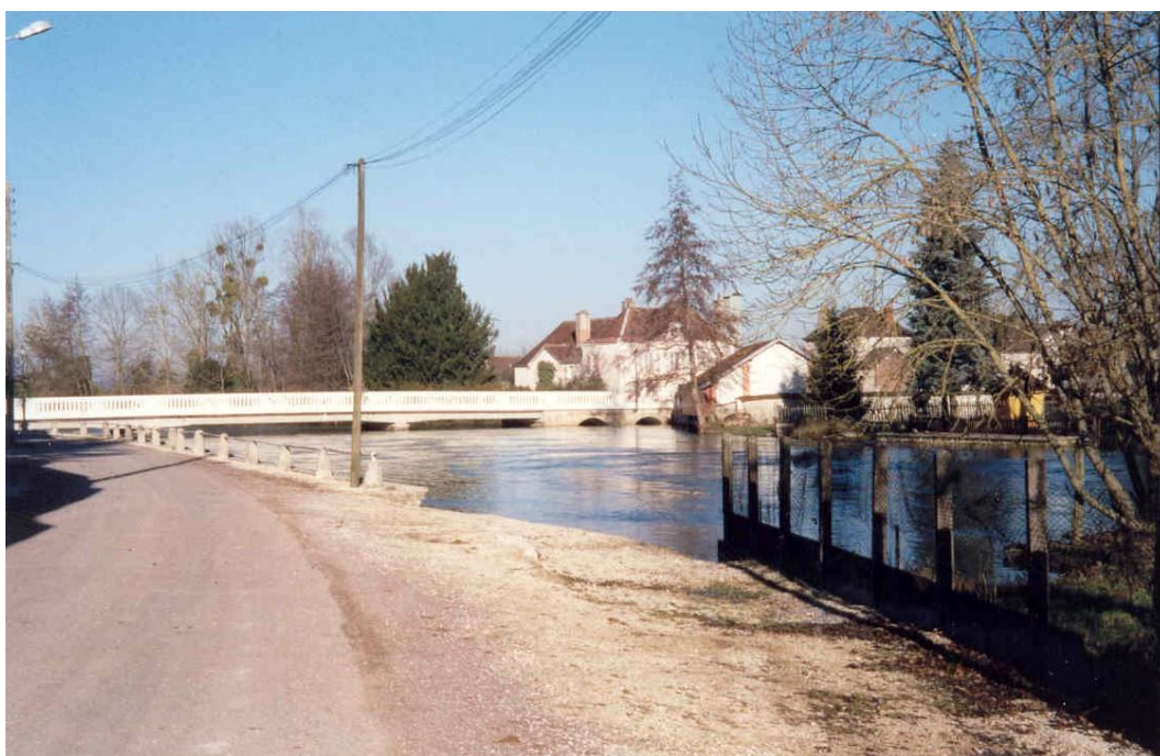
Cet espace nécessiterait un aménagement/traitement ou entretien spécifique. Les abords de Seine pourraient être aménagés en sentiers piétonniers
