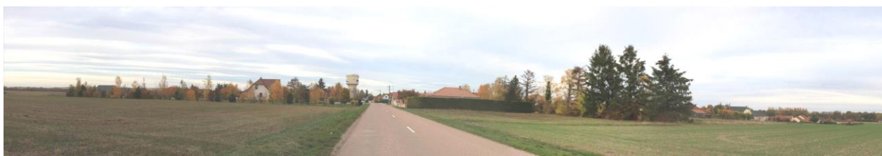
Vue sur l'entrée de ville Ouest, depuis la Rue de la Gare – Une silhouette qui change la ligne d'horizon plate de la Plaine
