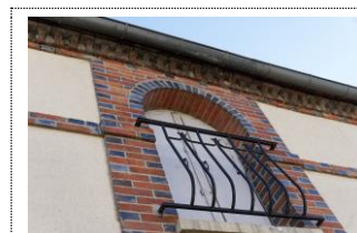
Élément de décor bâti ancien à conserver ou à remplacer à l'identique
