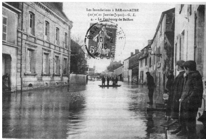
Bar-sur-Aube : Crue de 1910
