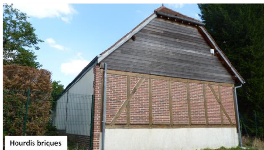
Hourdis briques plates et tuiles mécaniques
