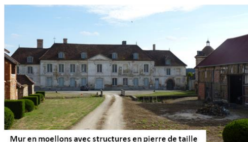
Mur en moellons avec structures en pierre de taille
