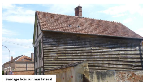
Bardage bois sur mur latéral
