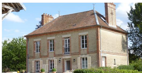
Mur en pierre légèrement travaillée avec structures en briques
