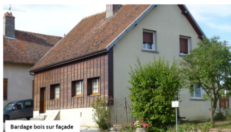
Bardage bois sur façade
