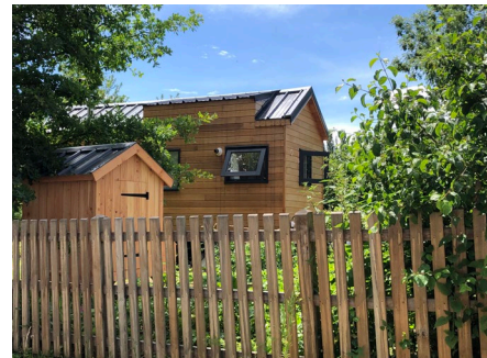
Constructions Rue de la Lapinière
