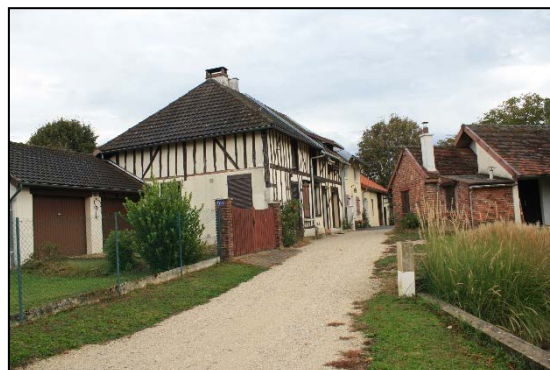
Ferme à cour, rue Raymond Poincaré.
