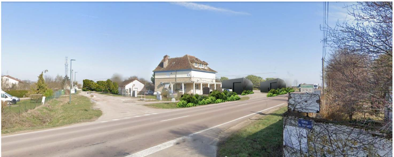
Vue de l'intersection de Lusigny avec un exemple d'emprise des bâtiments d'activités
