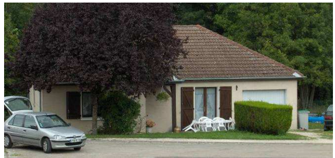
Lotissement près de Roche
