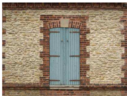
Encadrement en brique, rue du Bourg
