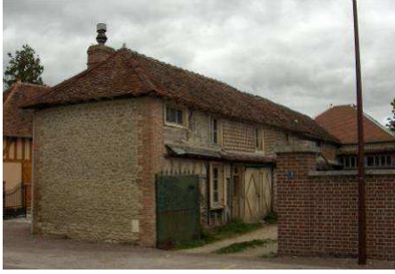
Fermette traditionnelle, rue de Chatel
