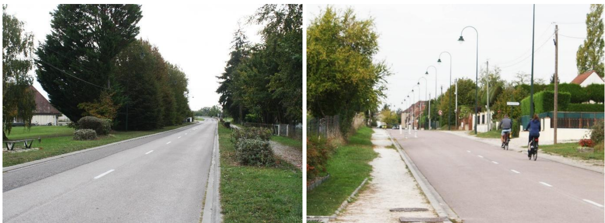
Absence d'aménagements pour la traversée des cycles
