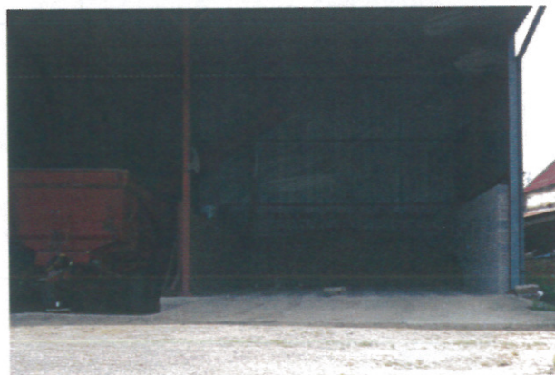
Stockage de grains et de matériel agricole
