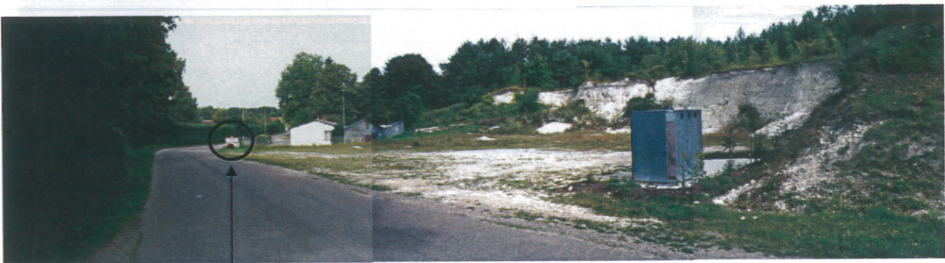
Entrée de La Fosse par Corduan (5)
