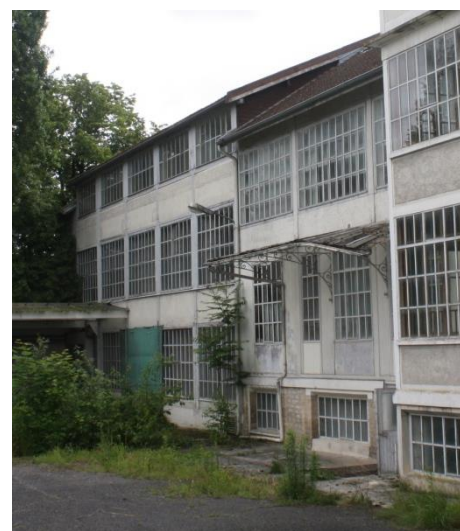
Atelier de fabrication et bureaux de 1907 au fond en 2016 (Perspectives, 2016)
