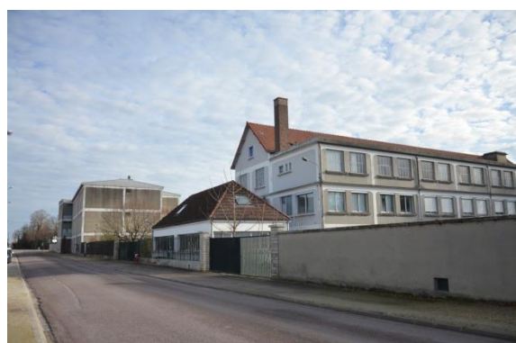
Façade Nord du bâtiment dit "le centenaire" en 2016 (Perspectives, 2016)
