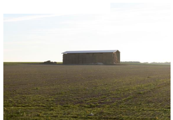
Hangar agricole au Sud de la commune
