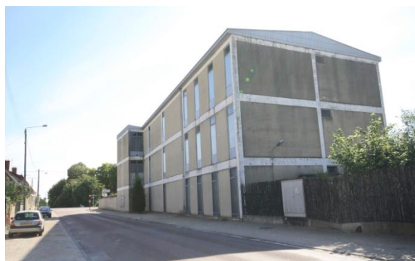
Bâtiments de stockage vus depuis le Boulevard Doré (Perspectives, 2016)
