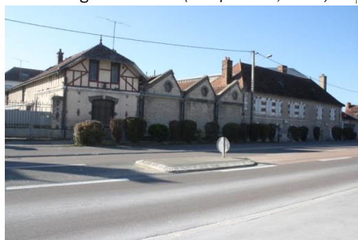
Salle des machines et conciergerie depuis la RD619 en 2016 (Perspectives, 2016)
