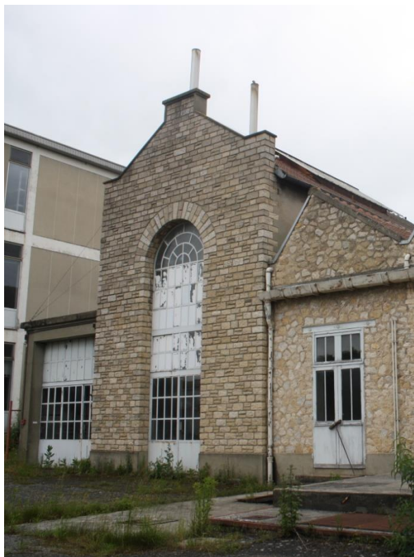
Façade Ouest de la chaufferie en 2016 (Perspectives, 2016)
