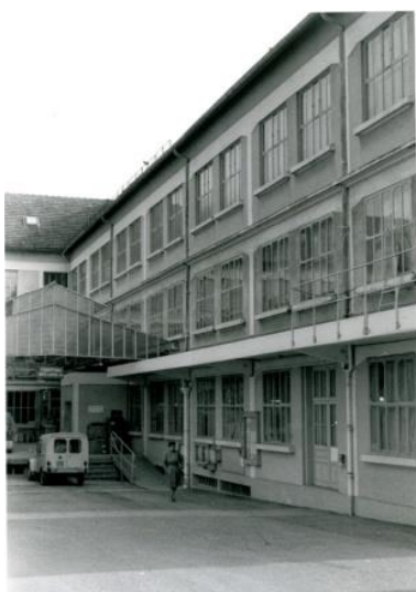
Bâtiment dit "le centenaire" et quai de chargement en 1986 (Région Champagne Ardenne Inventaire général, 1986)
