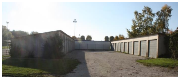
Garages collectifs rue du Stade (Perspectives, 2015)
