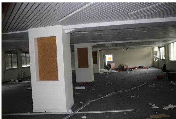
Intérieur du bâtiment dit « le Centenaire » Doré Doré, Fontaines-les-Grès (10) Photo : Perspectives 2016
