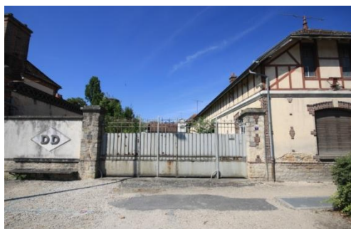
Entrée principale de l'usine (A 3 ) (Perspectives, 2016)
