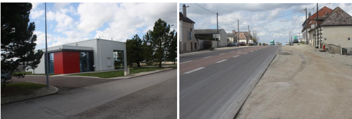
Volume simple des bâtiments d'activités et front bâti sur la RD619
