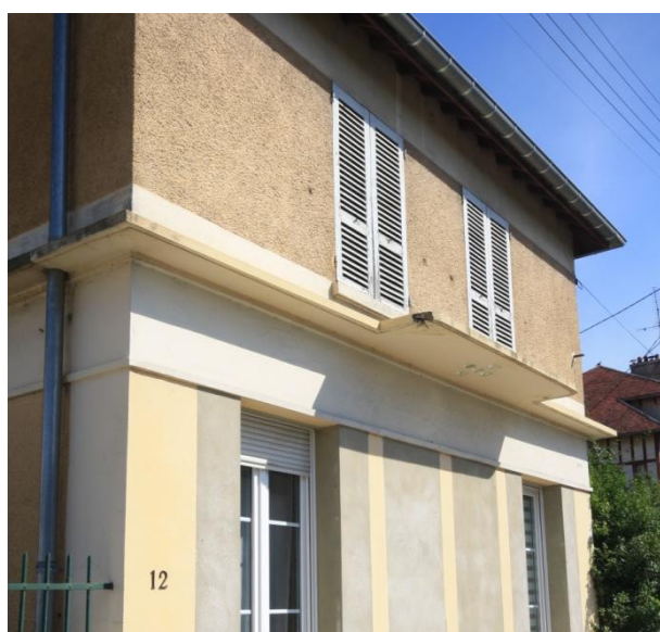
Marquise en béton (Perspectives, 2016)
