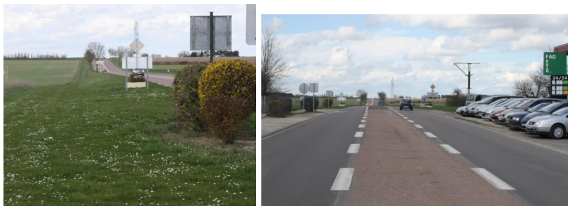
Talus côté Ouest et pente de la RD619
