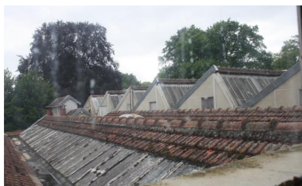
Vue sur les sheds des bâtiments de 1914 et 1929 (Perspectives, 2016)
