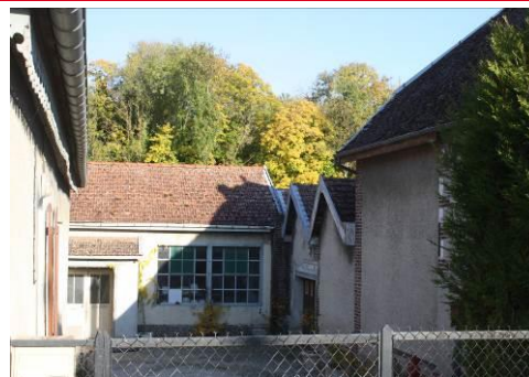
Atelier artisanal. Avenue du Maréchal Foch
