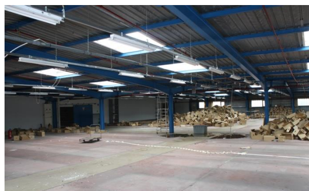
Intérieur du bâtiment de stockage (Perspectives, 2016)
