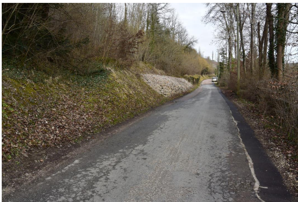
Illustration 4 – Enrochements et massif drainant réalisés depuis (source : BRGM, Février 2015)
