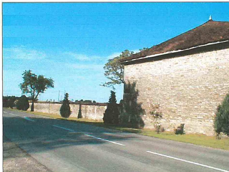
Loi Paysage : muret de ceinture de l'ancien corps de ferme bourg, de valeur esthétique et historique.
