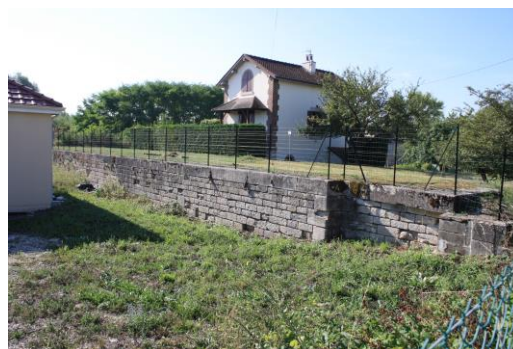
Ancien mur de l'écluse, Canal sans eau
