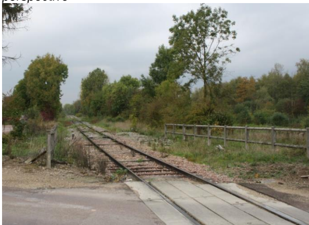
Boisements le long de la voie ferrée
