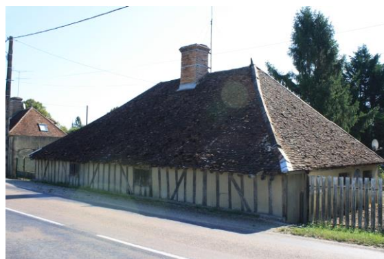
Toiture basse à 4 pans
