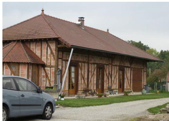
Grange réhabilitée en habitation
