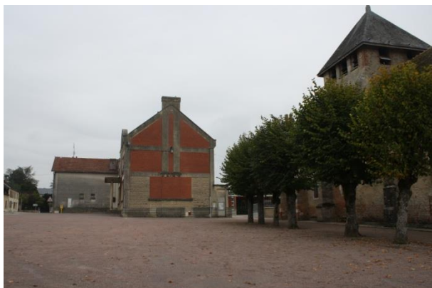
Aire de stationnement devant l'église et à proximité des écoles
