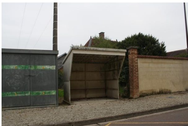
Arrêt rue de la vallée de la Seine
