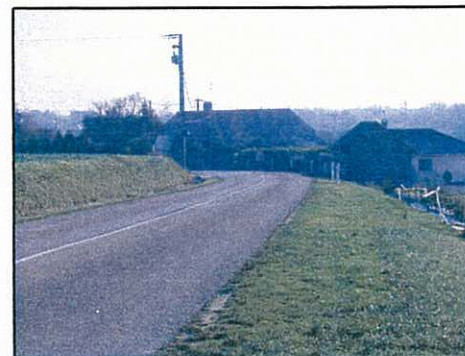
Renforcer la sécurité en entrée du village
