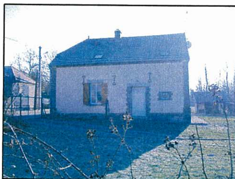
Réhabilitation utilisant des matériaux traditionnels
