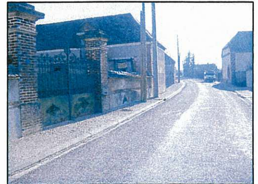
Clôture le long de la rue des Grandes Communications
