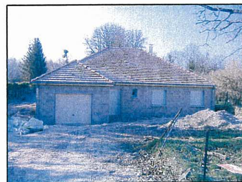
Construction en cours, rue Pavillon Sainte Julie
