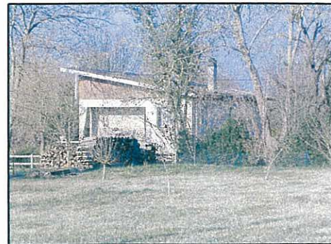
Toiture à une pente, rue Pavillon Sainte Julie
