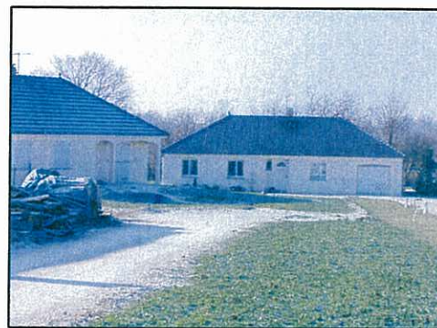
Construction neuve, rue du Moulin
