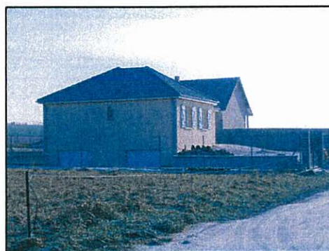
Toiture en béton noir, aspect ardoise
