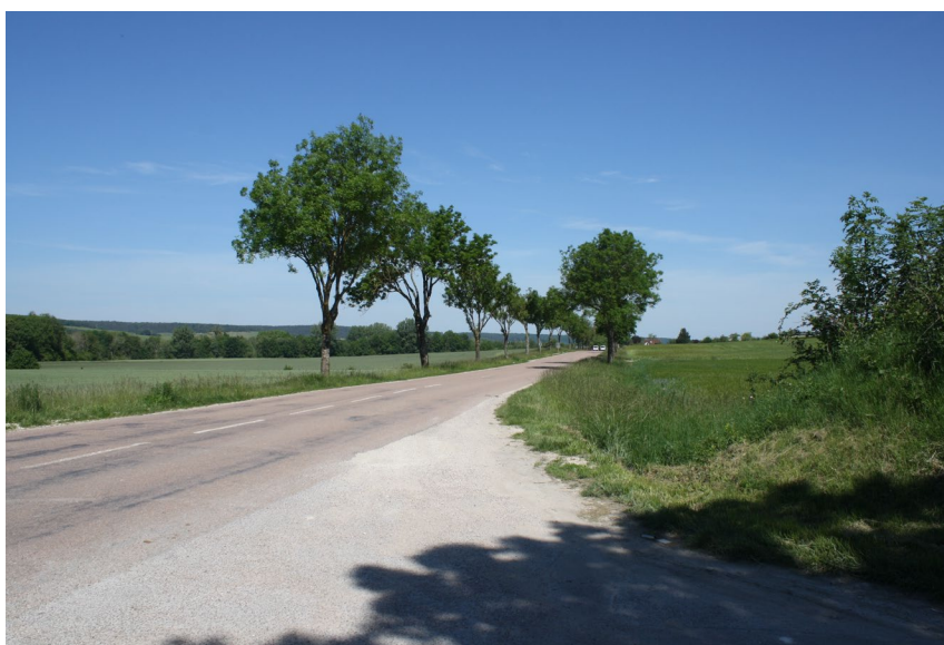
RD971 au sein de l'espace agricole
