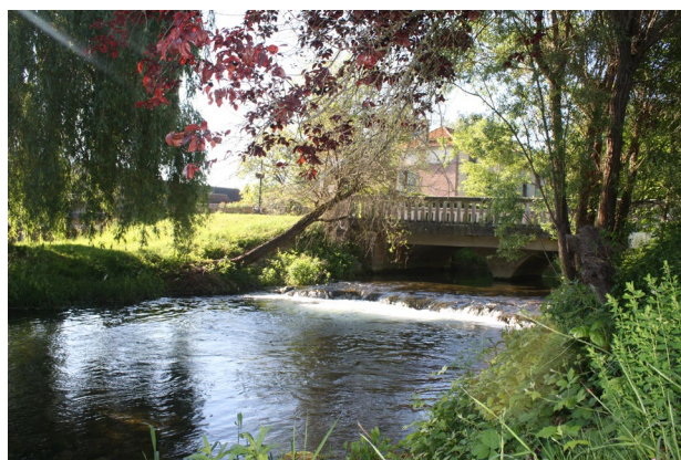
Pont sur la Seine - Rue des Ponts
