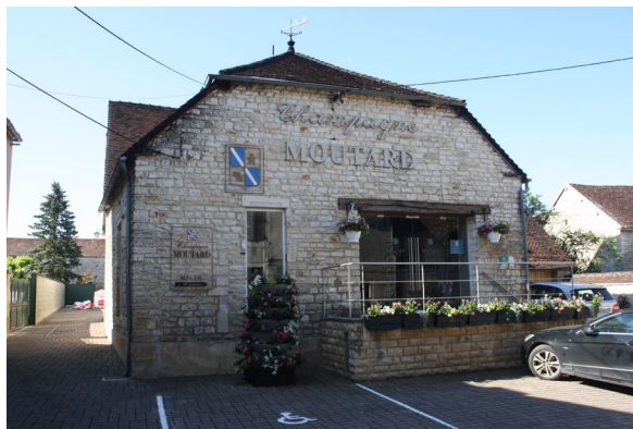
Exemple d'une construction en pierres
