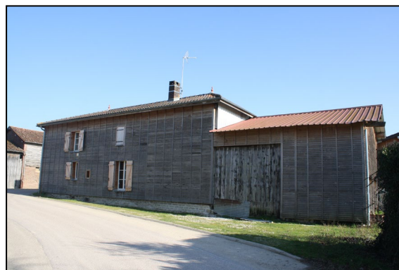
Maison en bardage bois rénové
