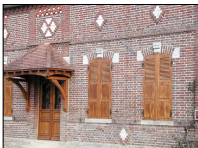
Mur de briques dont certaines, plus foncées, sont vernissées pour l'esthétique
