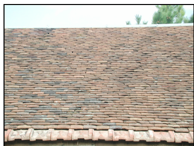
Toiture traditionnelle en tuile plates (rajout de tuiles mécaniques)
