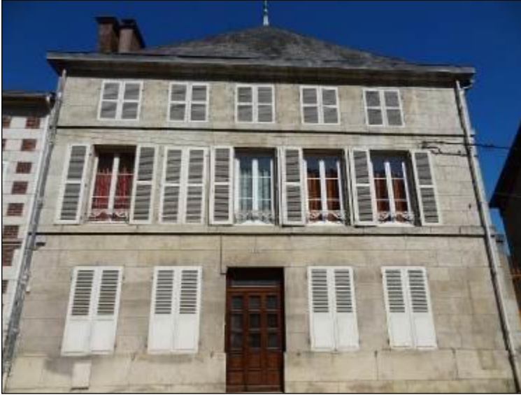
Construction en pierres de taille.
