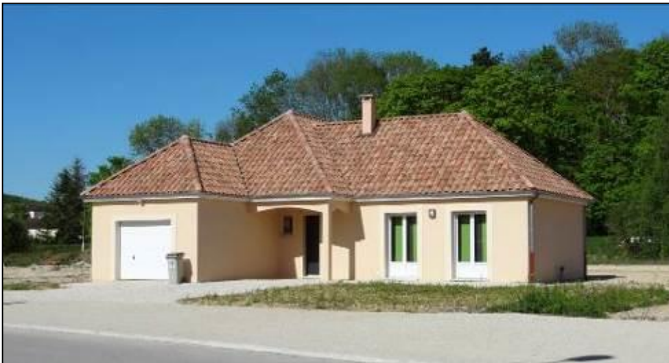
Nouvelles constructions en extensions urbaines avec toiture de tuile mécanique
