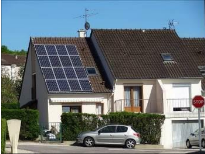
Nouvelles constructions avec intégration d'un dispositif à économie d'énergie
