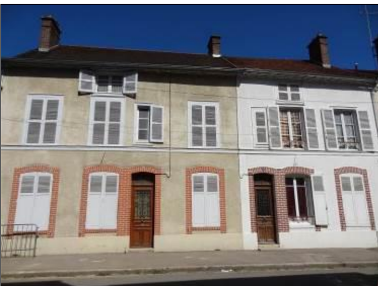
Construction avec façades enduites et briques peintes.
