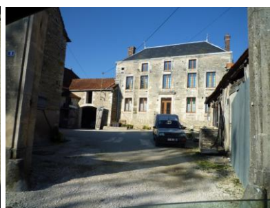
Haut mur clôturant la cour en U
