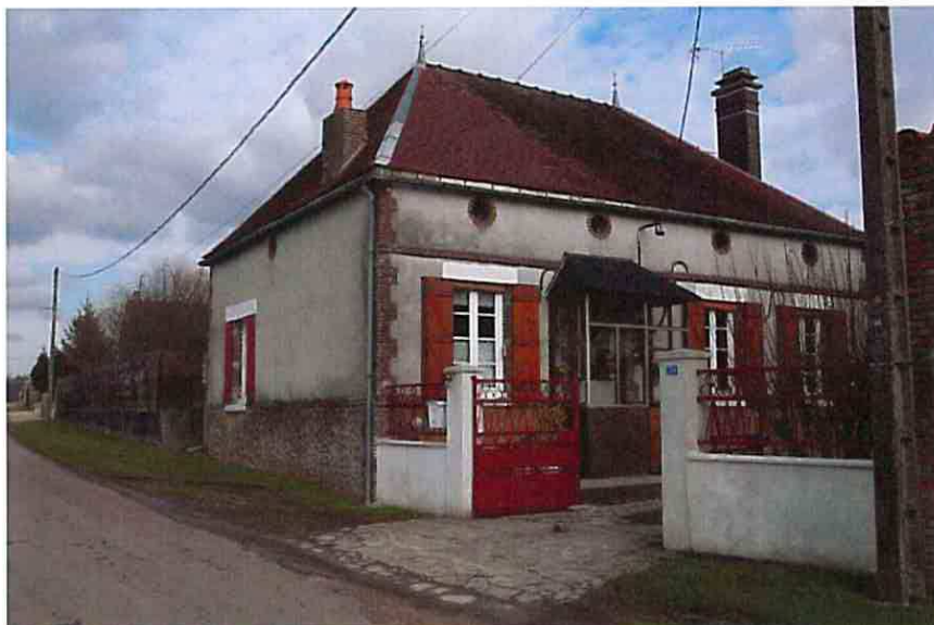
Rue du Moulin à SIVREY
