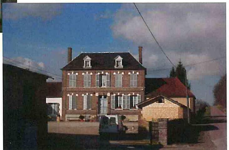
Rue des Bruyères à COSDON
