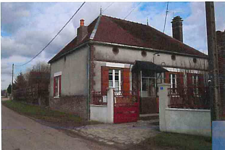
Rue du Moulin à SIVREY
