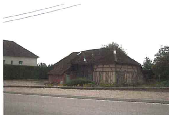
Zone inondable au centre du village
