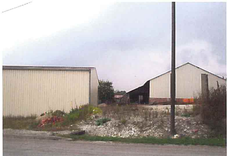
Bâtiments agricoles rue des Clots non accompagnés de traitement paysager
