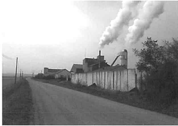
Usine de déshydratation le long de la départementale 100
