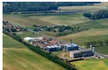
La CAPA en entrée Nord
