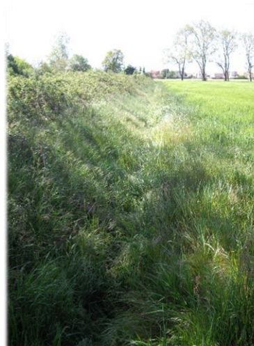
Galage ouverte, enherbée, avec présence de ronces en partie supérieure
