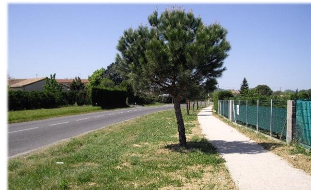
Aménagements sécurisés le long de la RD 129
