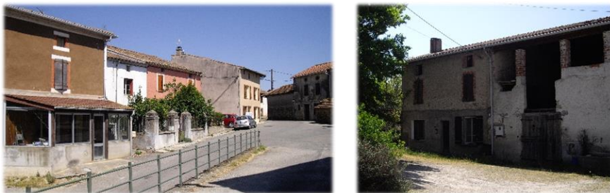
Le bâti du noyau ancien : des constructions aux volumes simples, dont certaines à valoriser
